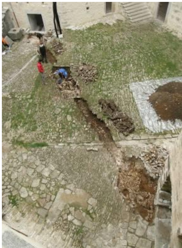
Pogled na trasu kanalizacijskog odvoda
