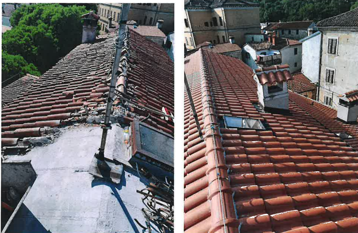
Sanacija kosog krova na zgradi Istarskih glagoljaša 2, u Pazinu
