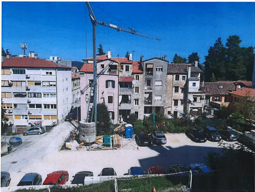
Sanacija kosog krova na zgradi M. B. Rašana 4, u Pazinu;
