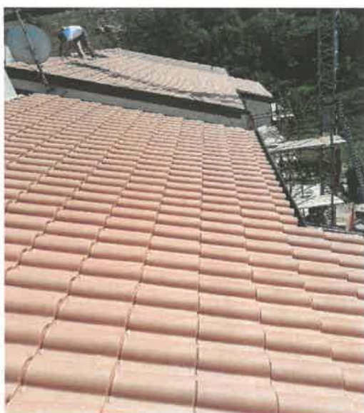
Sanacija kosog rova na zgradi Saše Šantela 17, u Pazinu
